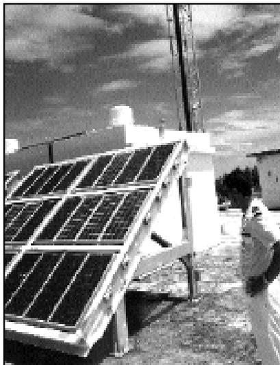
Après le nucléaire, le solaire : Centre nerveux du **système de détection et de protection** des sites TELSITES, sur l'ancien bunker PCT. Toutes les données sont expédiées par satellite (transpondeurs ronds) à Tahiti et en France. En cas de mouvement des sols, l'alerte des légionnaires par le "BIPS" est faite automatiquement en direct par les installations de l'atoll.
